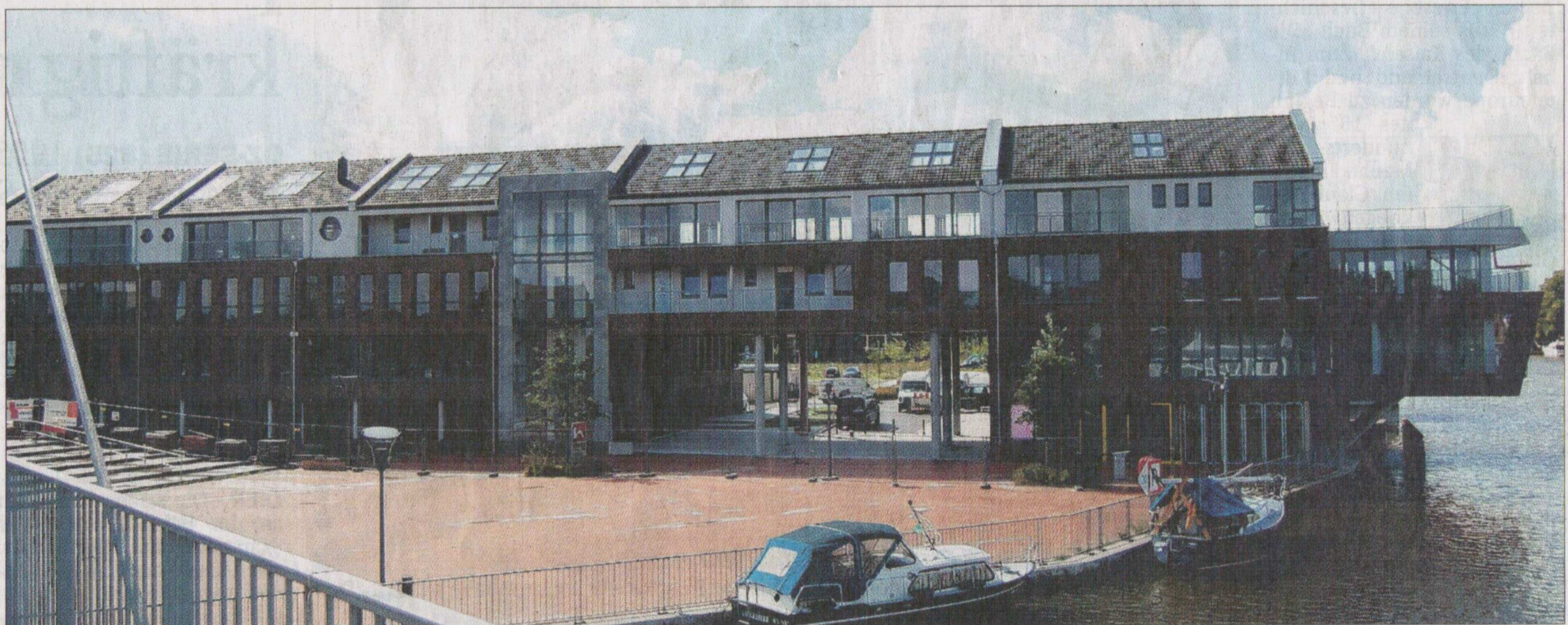
Seit zwei Jahren wird an dem Torbogenhaus neben der Nessebrücke gearbeitet. Die ersten Bewohner und Firmen sind bereits eingezogen.
