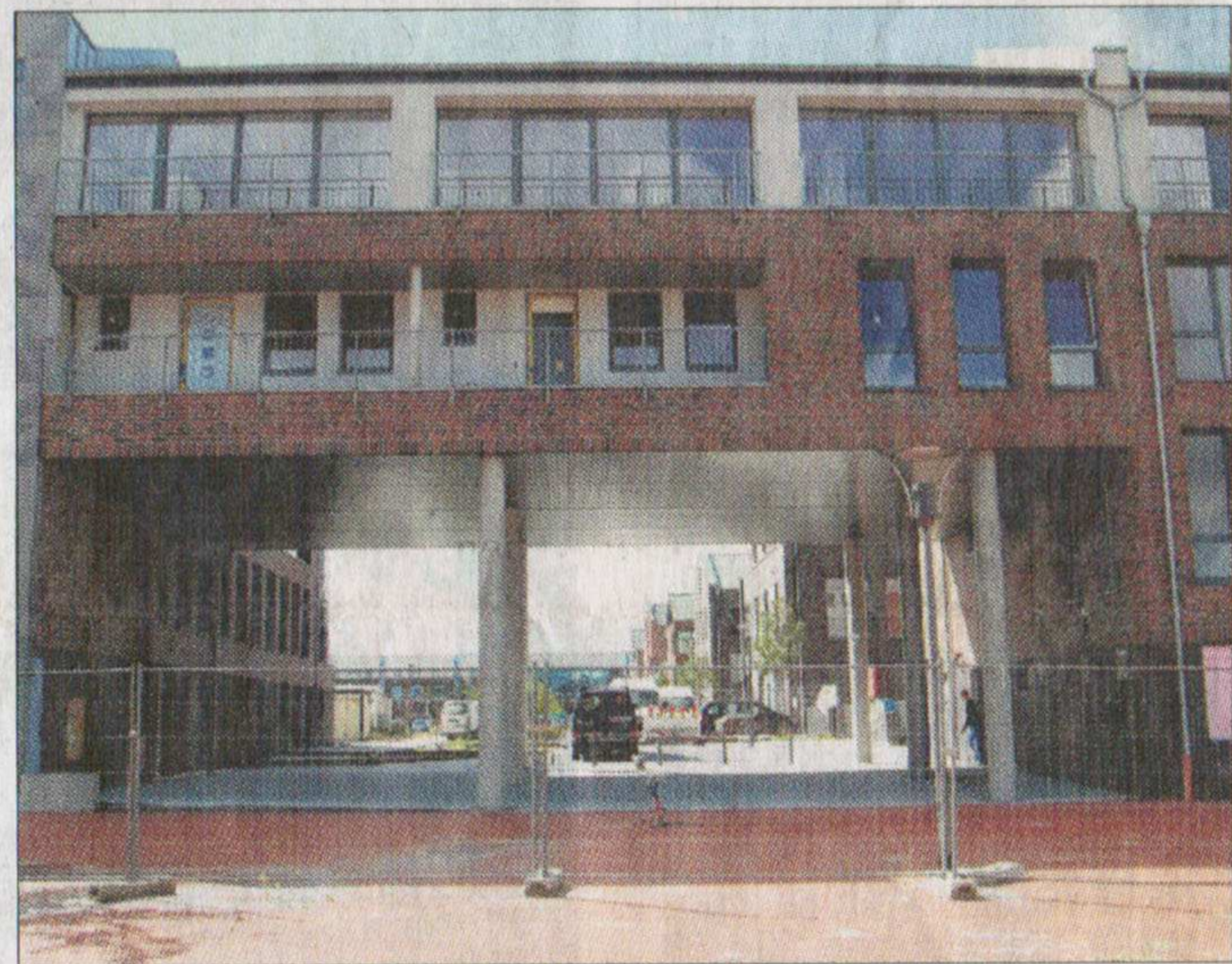
Aus Gründen der Sicherheit ist die Durchfahrt zum Torhaus an der Nessebrücke noch gesperrt.
