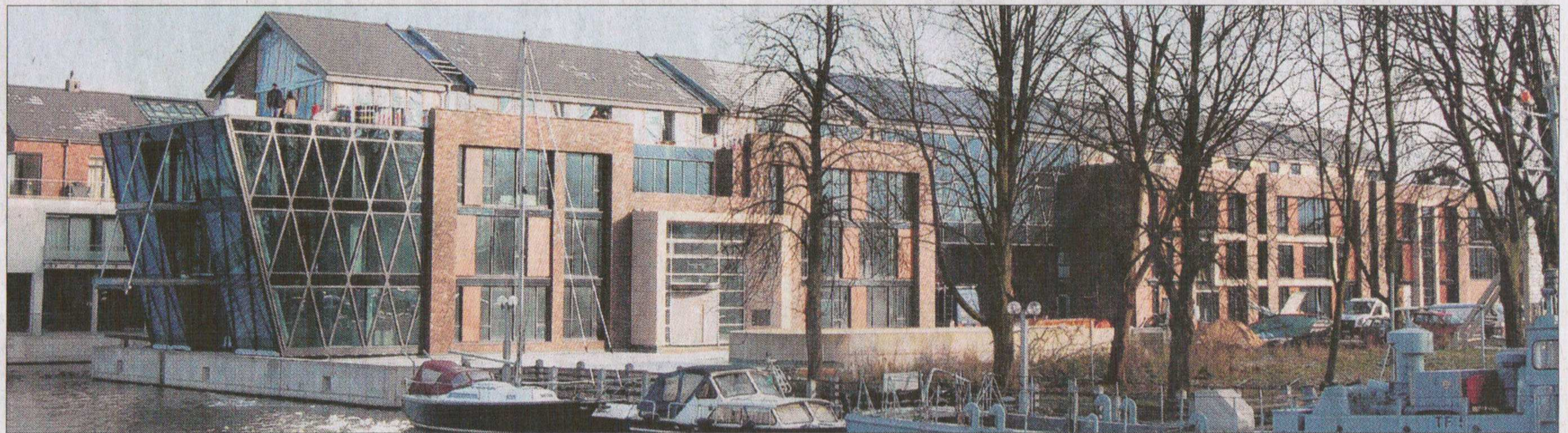
Das Torbogenhaus an der Rathausbrücke ist größtenteils fertig. In den nächsten Tagen werden die Beschäftigten des Bauherrn, der Gesellschaft für Handel und Finanz, einziehen.
