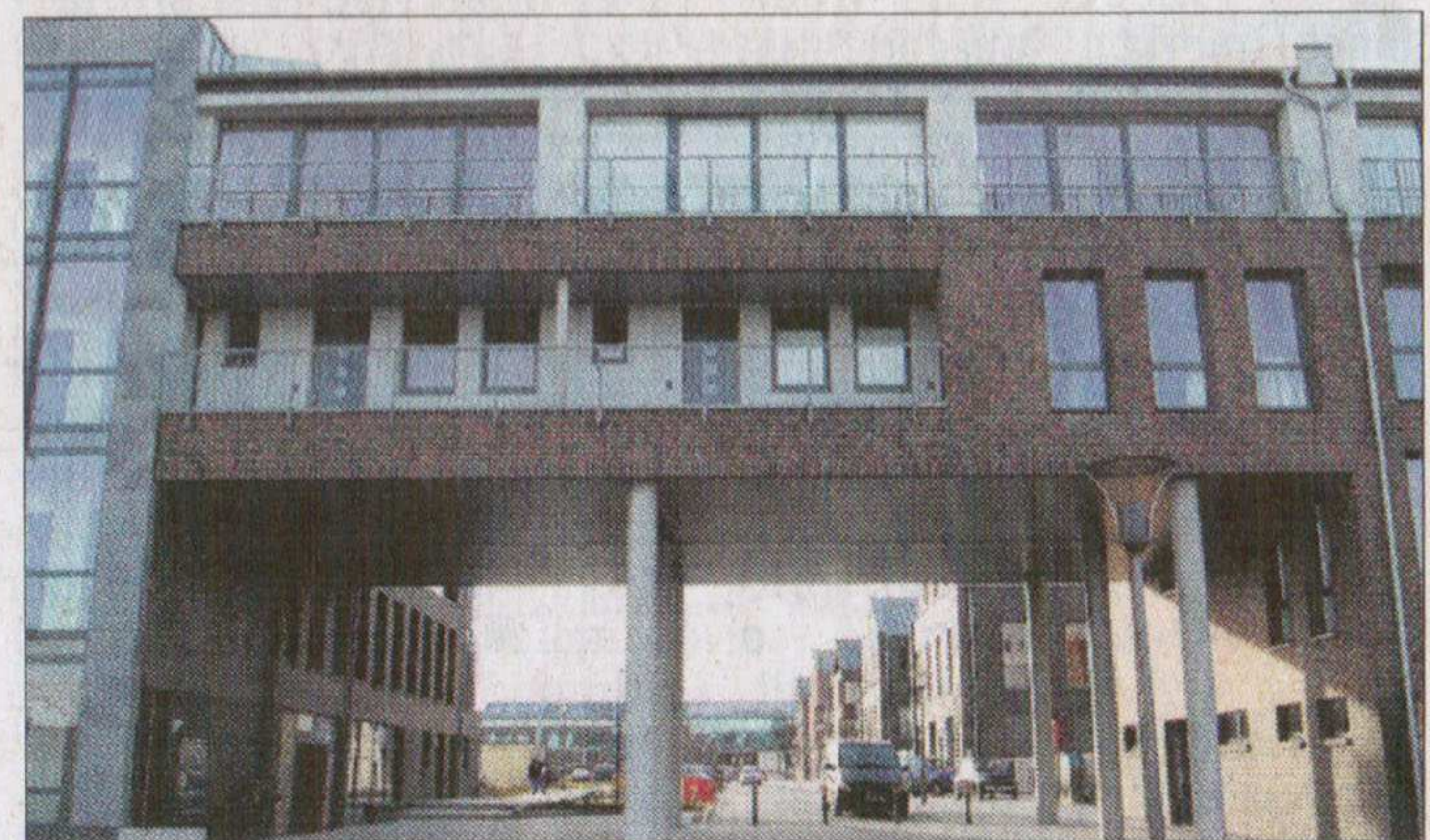
Das erste Torbogenhaus an der Nessebrücke kann bereits passiert werden.
