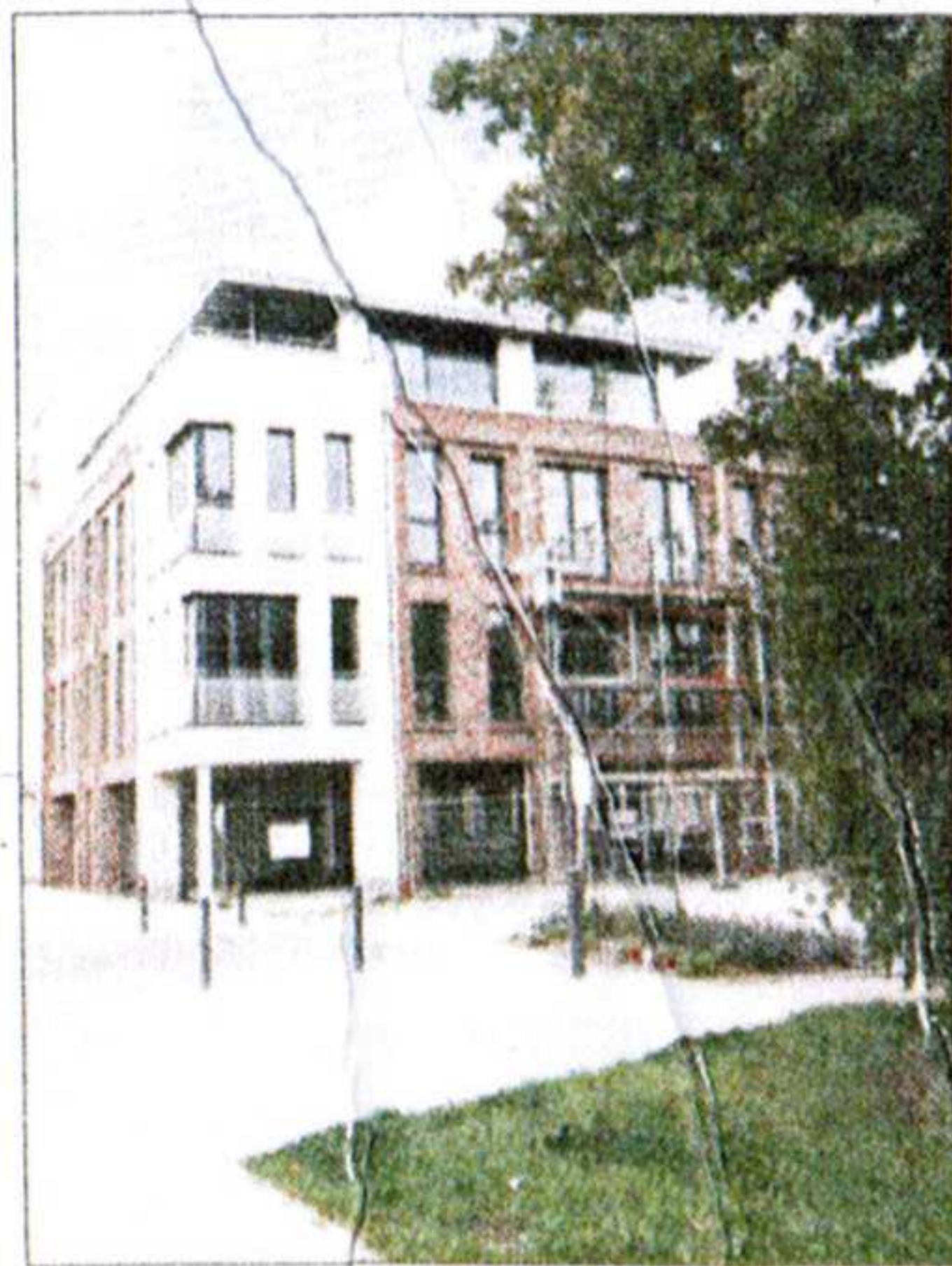
Das Gesundheitszentrum am Eingang des Nessequartiers ist fast fertig.
