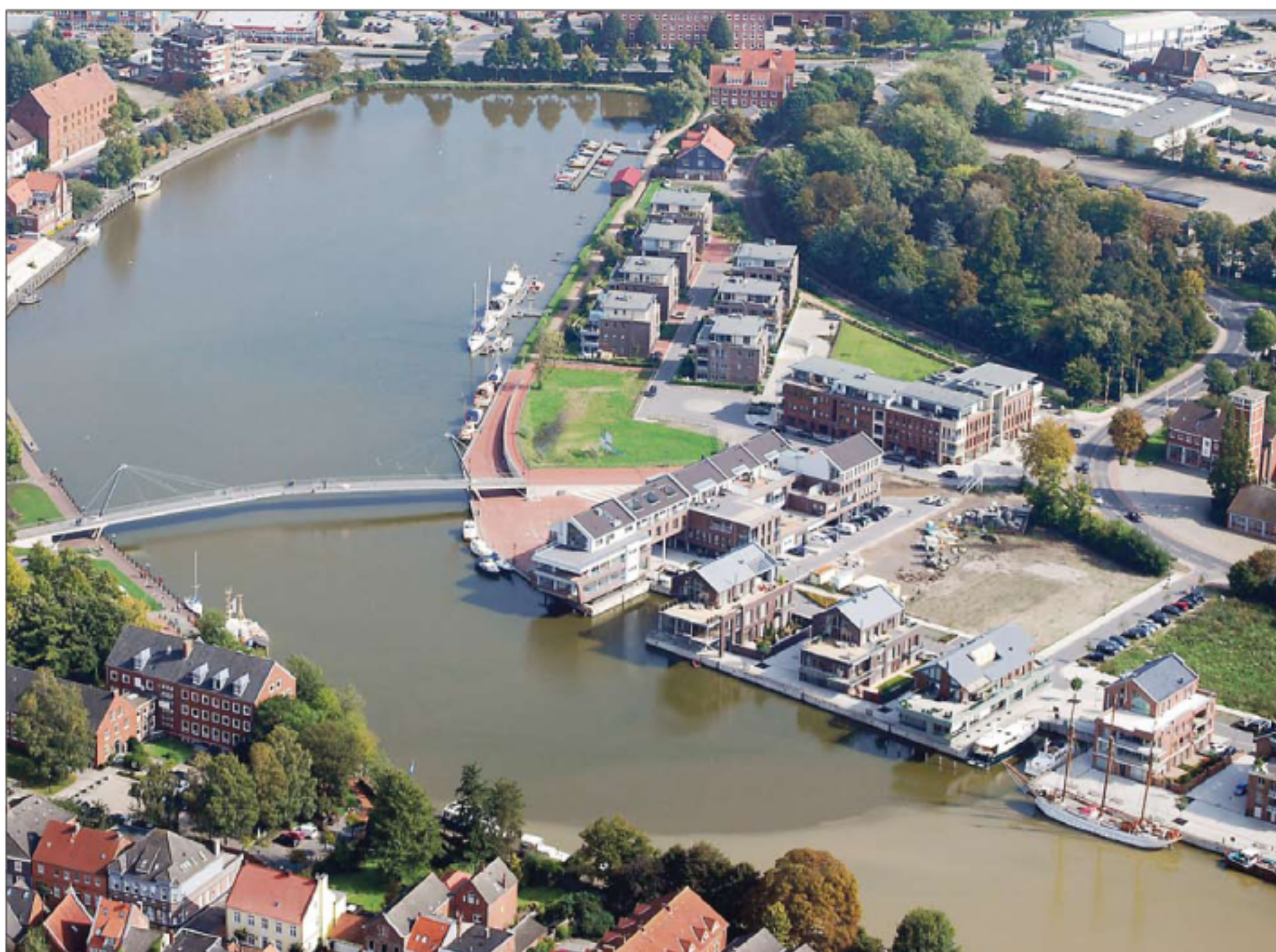
Das Torbogenhaus auf dem so genannten „Baufeld 11“ direkt neben der Nessebrücke geht seiner endgültigen Fertigstellung entgegen. Den Planern und ausführenden Unternehmen ist ein neues Schmuckstück für das Gesamtensemble am alten Handels-hafen gelungen. Foto: Hans-Peter Heikens
